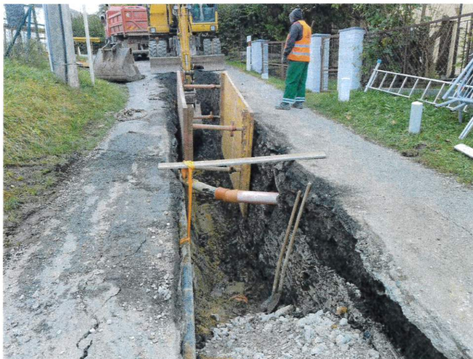
Obrázek 1 Výkopové práce na stavbě mezi Š4/11 a Š4/13, stoka C4
