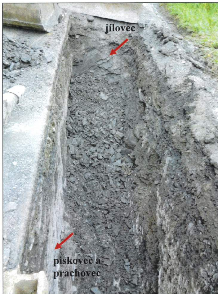
Foto 1 Horniny (shora jílovec, níže pískovec) ve výkopu pro stoku C4
