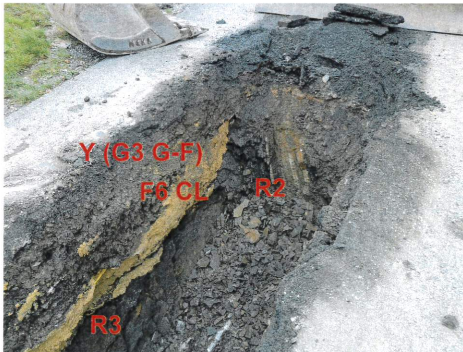
Obrázek 7 Výkop kanalizace mezi Š4/11 a Š4/13, stoka C4
