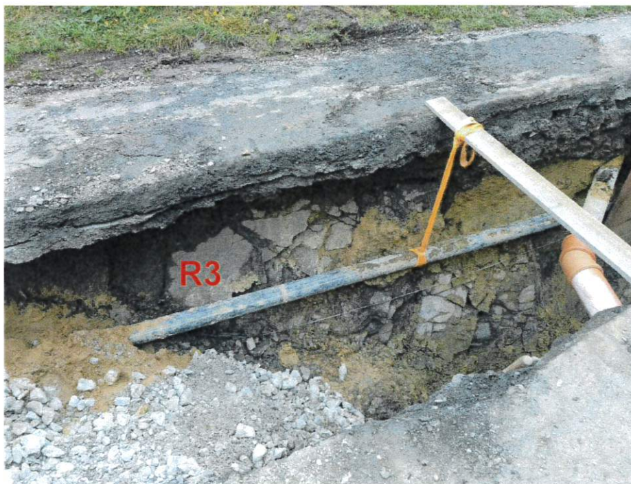
Obrázek 5 Výkop kanalizace mezi Š4/11 a Š4/13, stoka C4
